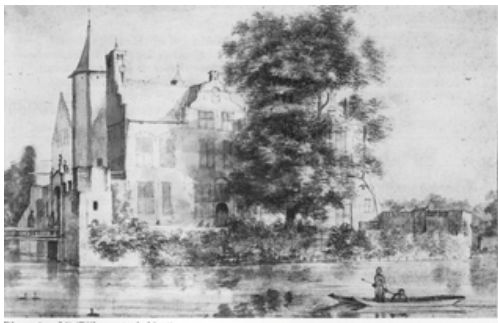
Voorgevel voor de verbouwing in 1842
